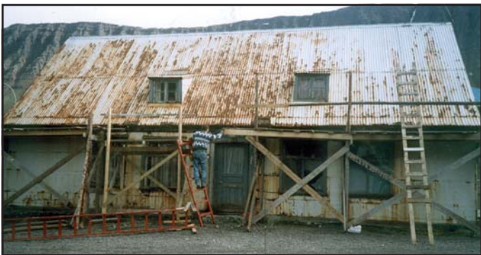
Svona leit Faktorshúsið út árið 1993, þá nánast að falli komið. Magnús Alfreðsson hugar að bráðabirgðalagfæringum utanbúss.
