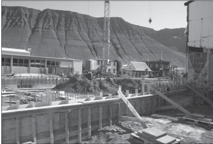
Byrjað er að steypa sökkla nýbyggingarinnar.
