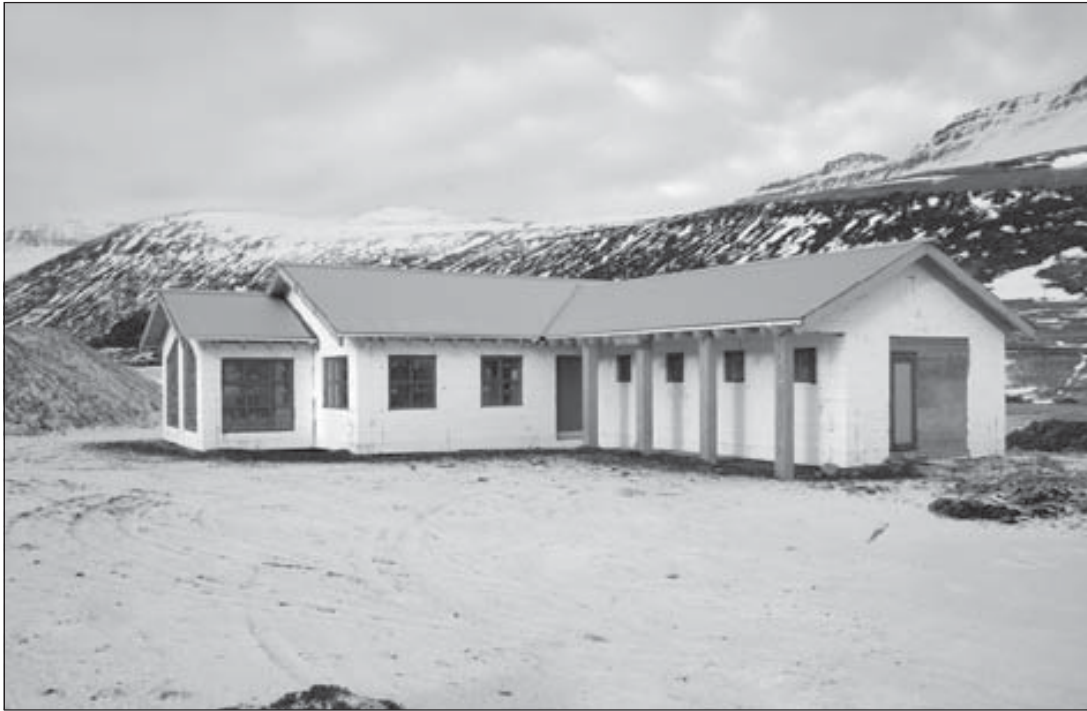
Eitt íbúðarhúsanna sem er í byggingu á Tunguskeiði er orðið fókheld.
