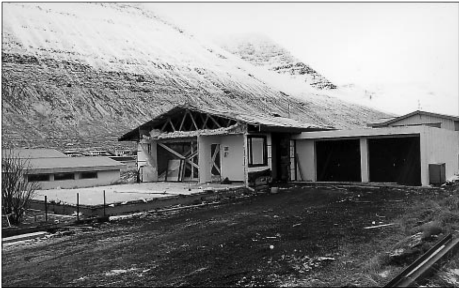
Hér er búið að taka helminginn af grunninum og koma honum fyrir á flutningabíl...
