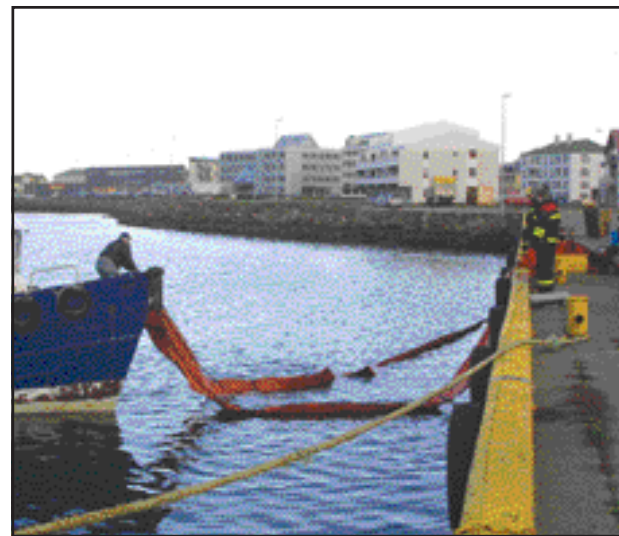
Hafnarstarfsmenn og slökkviliðsmenn komu mengunarvarnargirðingu fyrir.
