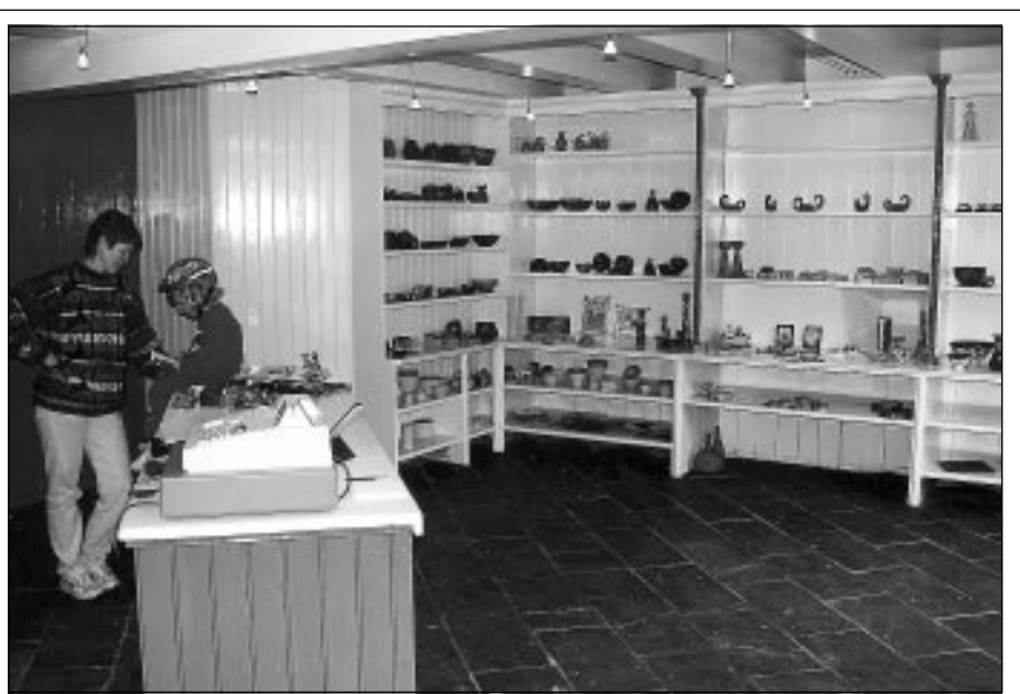
Gólfíð í nýju húsnæði Rammagerðar Ísafjarðar er lagt þakplötum úr steini sem einu sinni voru á þaki pósthússins á Ísafirði.
