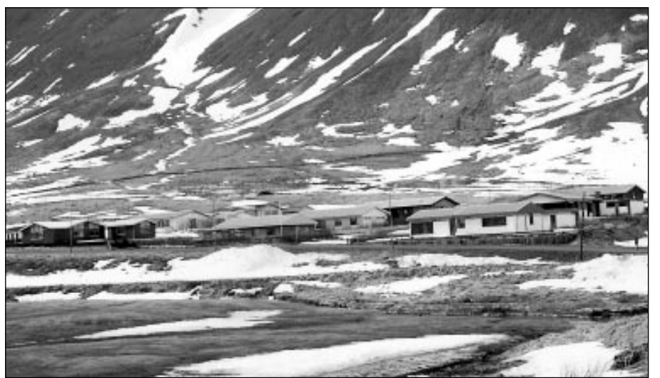
Stefnt er að sölu flestra húsa á snjóflóðahættusvæðinu í Hnífsdal.
