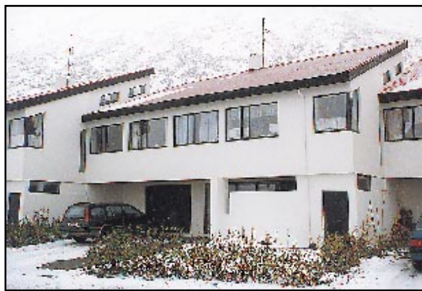
Urðarvegur 26: 236,9m 2 raðhús á tveimur hæðum ásamt innbyggðum bílskúr. Verð: 11.800.000,-
