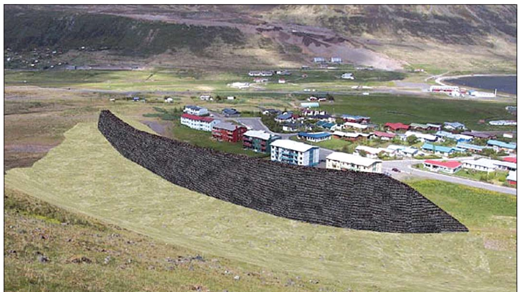
Teikning af snjóflóðavörninum sem reisa á í fjallinu Kubba í Skutulsfirði.
