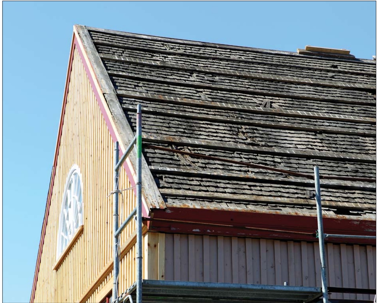
Á þessari mynd má sjá gömlu þakskífurnar sem leyndust undir þakplötunum.
