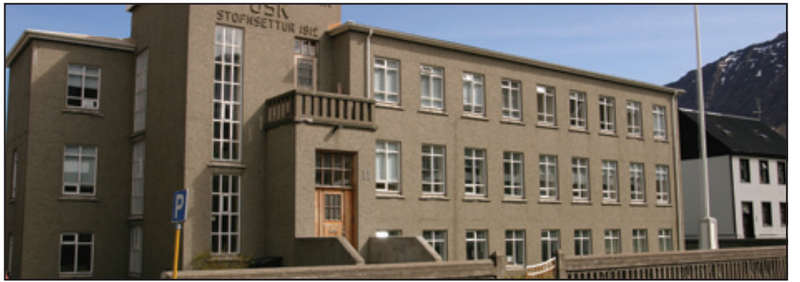
Framkvæmdir við hús TÍ verða boðnar út í kringum næstu áramót.
