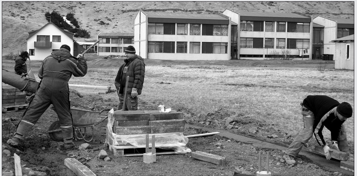
Starfsmenn Ásel steypa undirstöður fyrir auglýsingaskilti við innkomuna í þorpið.
