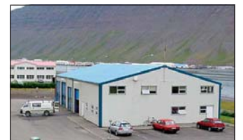
Þjónustumiðstöð Ísafjarðarbæjar á Stakkanesi.
