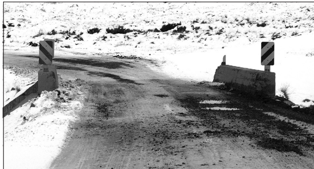
Eins og sjá má er Vestfjarðavegur 633 um Reykjanes vart neitt nema holurnar. Einbreyddar brýr hafa orðið mörgum góðum drengnum að fjórtjóni í gegnum tíðina.
