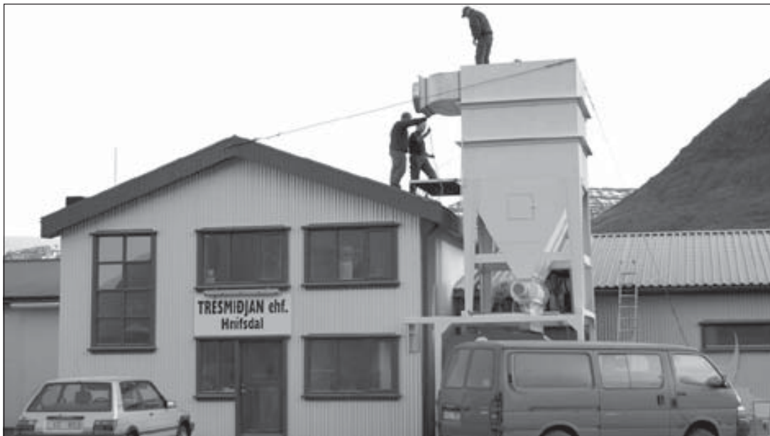
Hreinsibúnaðurinn settur upp hjá Trésmiðjunni í Hnífsdal. Ljósmynd: Þorsteinn J. Tómasson.
