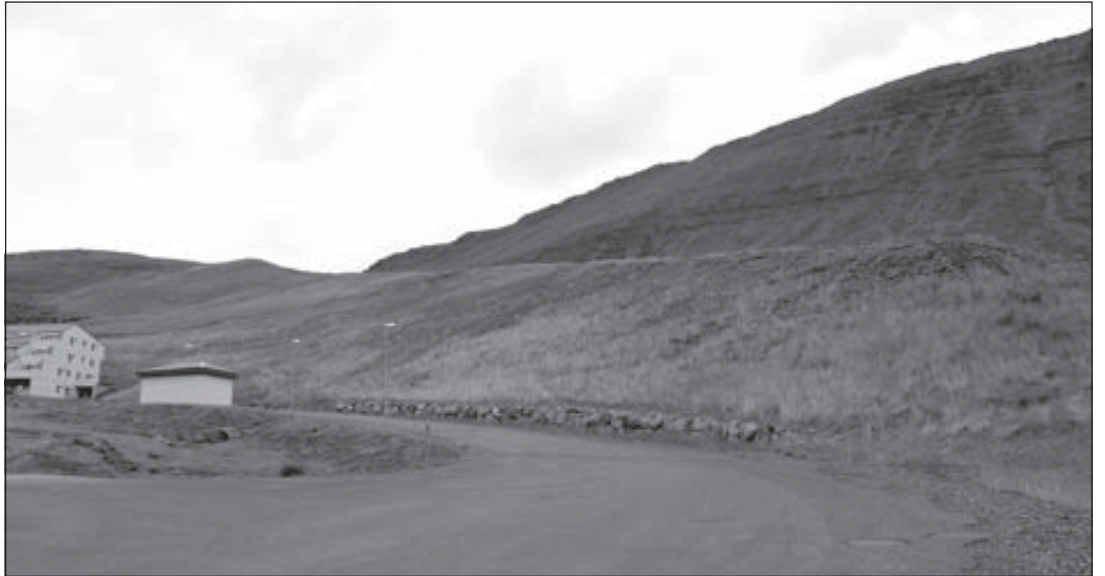
Snjóflóðagarðurinn við Seljaland
