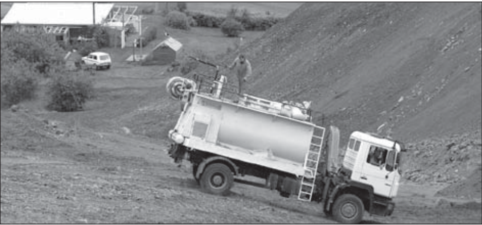
Unnið að uppgræðslu snjóflóðavarnargarða við Seljaland.
