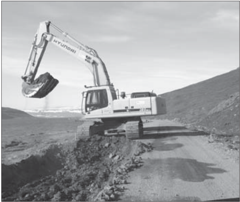
Frá framkvæmdunum við Djúpveg í Hestfirði.
