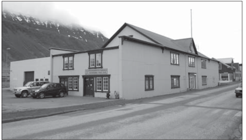
Edinborgarhúsið á Ísafirði þar sem upplýsingamiðstöð ferðamanna er til húsa.
