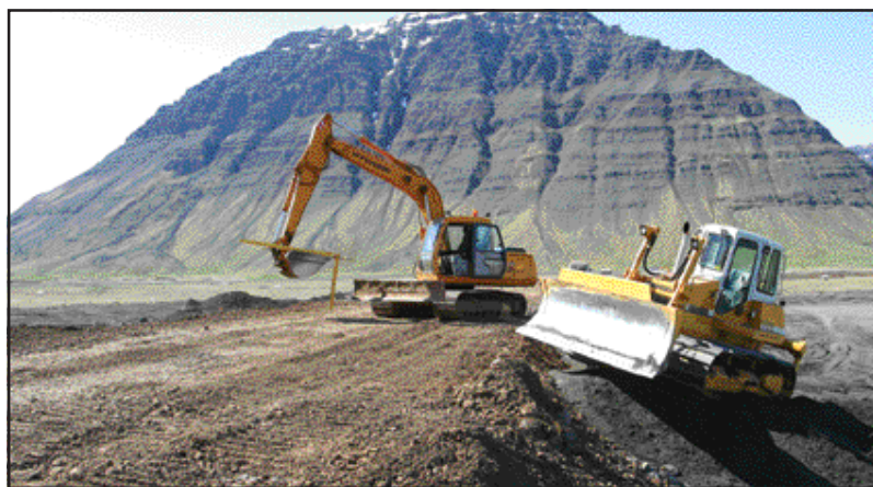
Frá framkvæmdum við nýja veginn.
