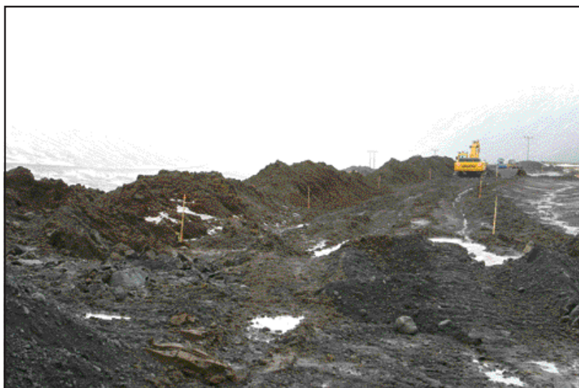
Frá framkvæmdunum við nýja veginn í Tungudal.
