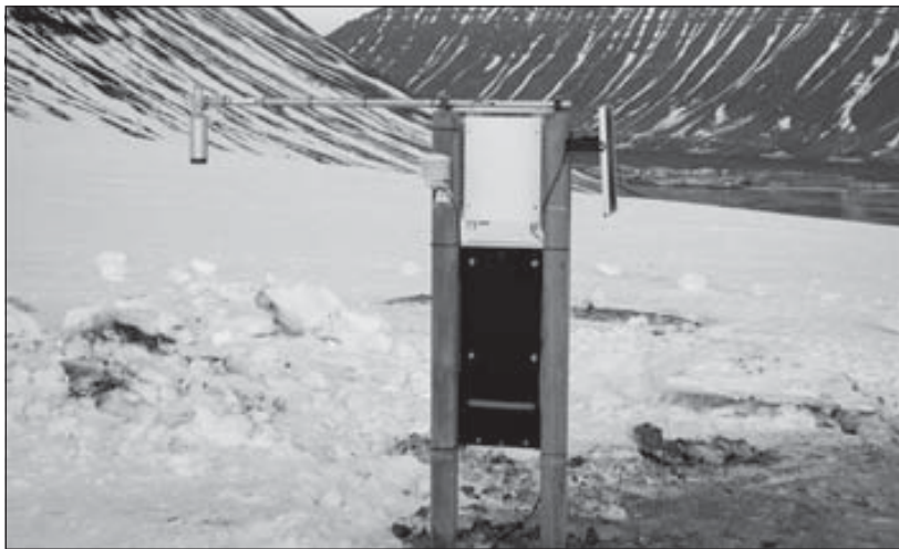
Ný veðurathugunarstöð var sett upp á Seljalandsdal í vikunni. Mynd: Haraldur Tryggvason.
