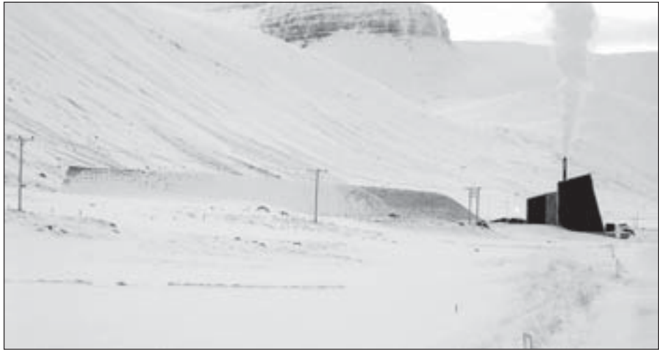
Snjóflóðavarnargarðurinn ofan við Funa. Mynd: Tómas Jóhannesson.
