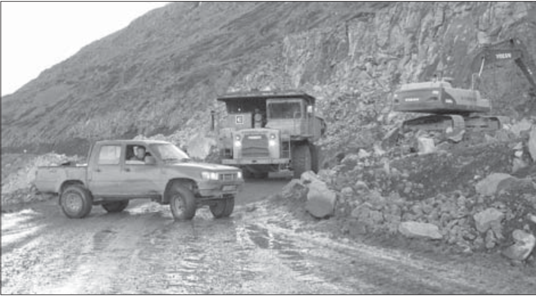
Unnið að vegagerð í Skötufirði í Ísafjarðardjúpi síðastliðið sumar.
