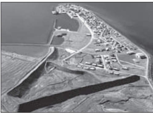
Varnargarðurinn sem reistur var á Flateyri í kjölfar snjóflóðsins 1995.
