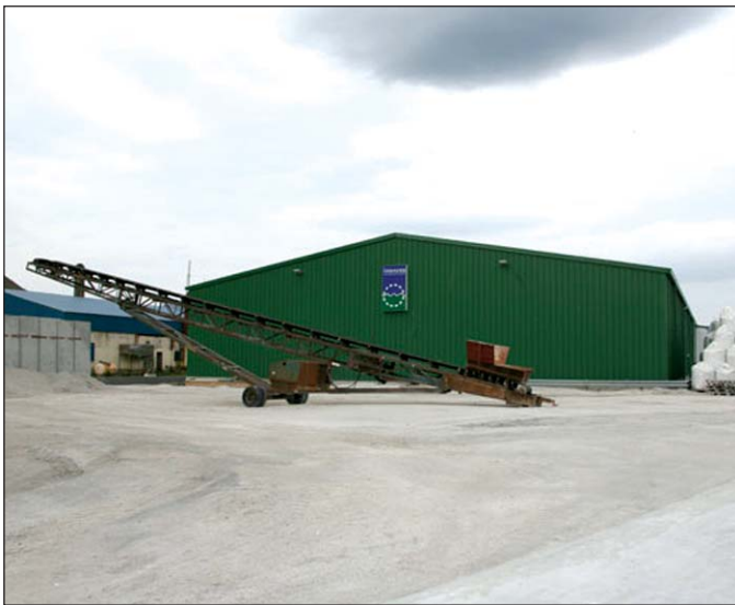
Kalkþörungaverksmiðjan á Bíldudal.
