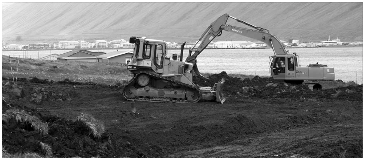
Frá framkvæmdasvæðinu í Tungudal.
