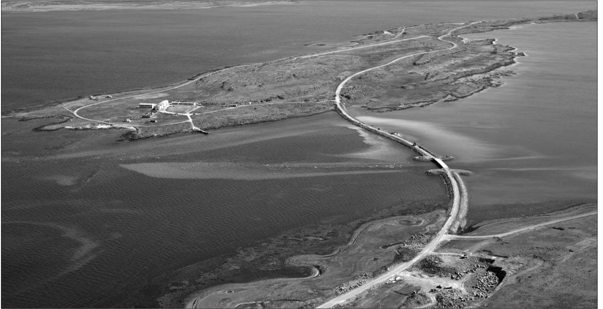
Unnið er í grjótgarði í Reykjafirði.
