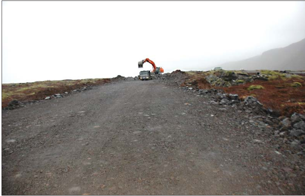
Frá framkvæmdasvæðinu: Ljós: www.vegagerdin.is.
