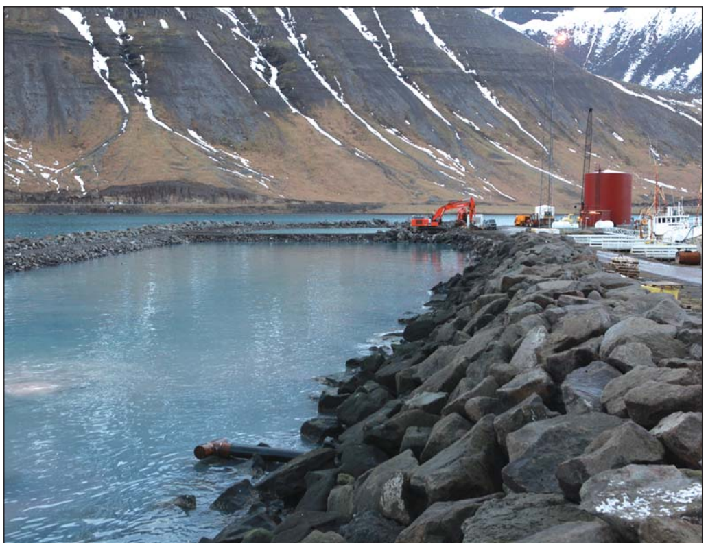
Stefnt er að því að framkvæmdum við Mávagarð verði lokið næsta vor.
